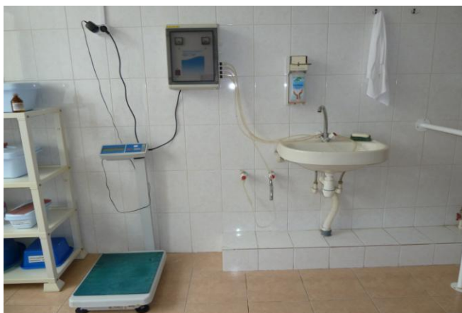
Монтаж установки СТЭЛ в процедурном кабинете.
